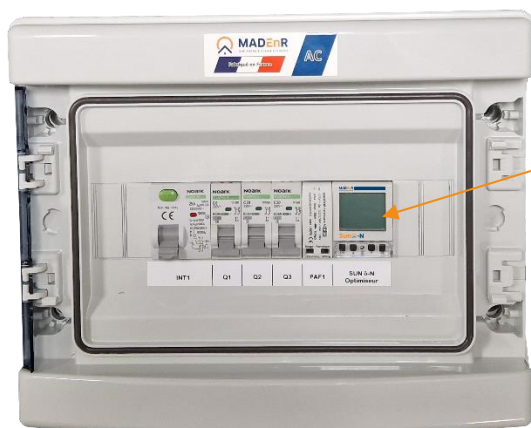
Figure 71 : Coffret AC pour micro-onduleurs type APS, 2 branches, avec intégration de l'optimiseur Sun Ô - N
