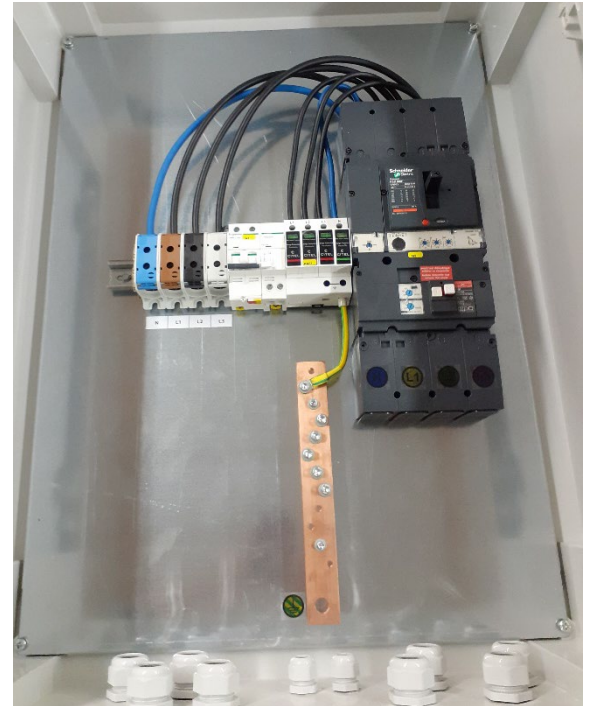
Figure 43 : Coffret AC TRI 1 onduleur option disjoncteur pour bobine Mx réf. 23410010 avec option sur demande (Presses étoupes montés vers l'intérieur pour le transport)
